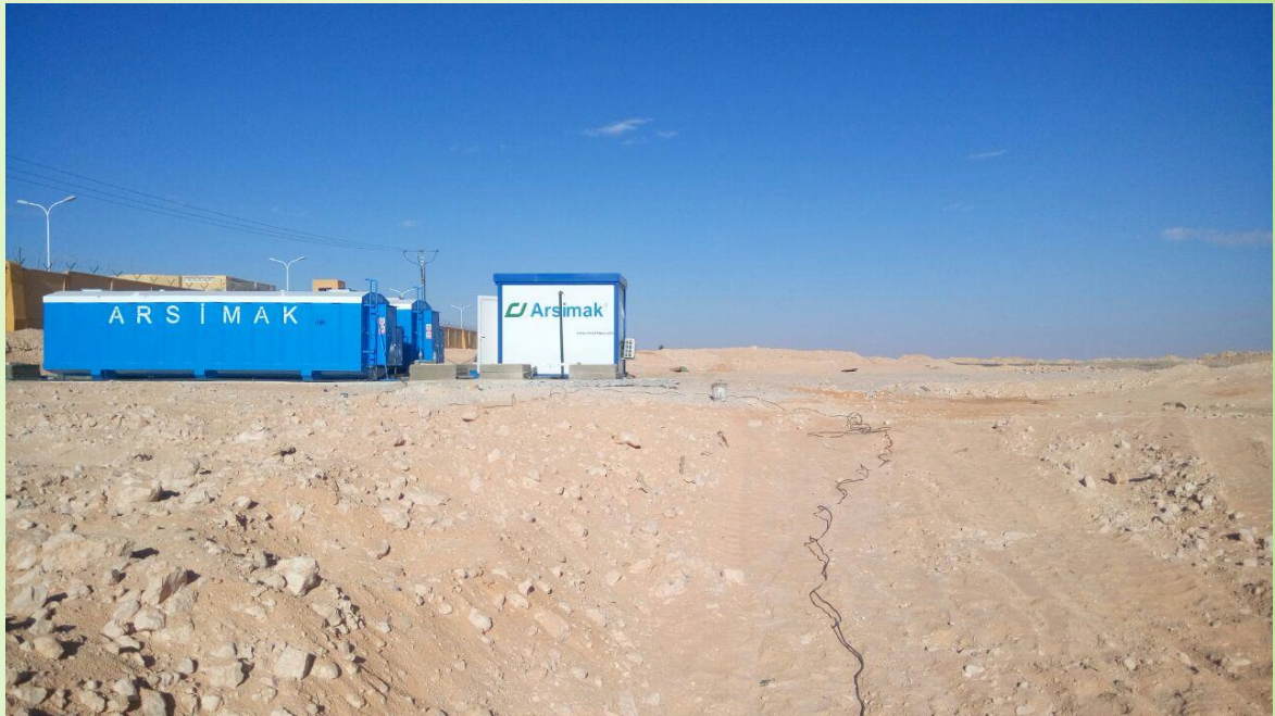
Station d'épuration de la base de vie d'ETRBH TIOUANE (W.OUERGULA)
